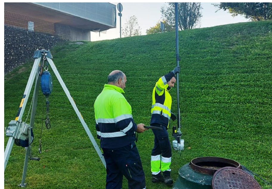
Trabajadores de Aquara realizando una inspección de la red de alcantarillado
